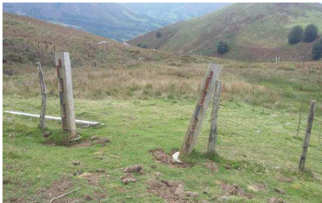
Los postones del portillo principal se han movido por efecto del ganado y deben recolocarse. No se trata de una acción urgente, ya que se prevé que el portillo permanezca abierto en verano de 2020.
